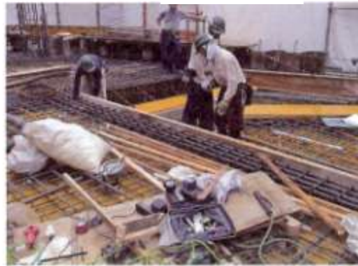
型枠作業が間に合わず、打設当日も雑然としたスラブ
