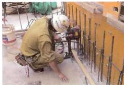
打ち継ぎ部上面からのコア採取作業。後日、上からコンクリートを打ち込むため、傷を残さずに品質確認を実施できる
