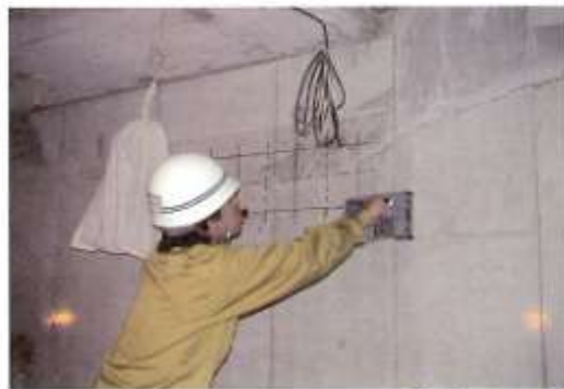
鉄筋探査作業
