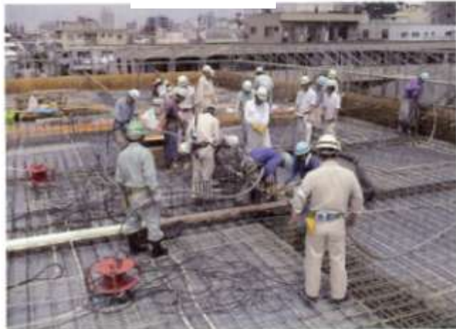
スラブ12以下の硬い生コンを、口径50mmのバイブレーターを3本以上使用し、多くの作業員で打設
