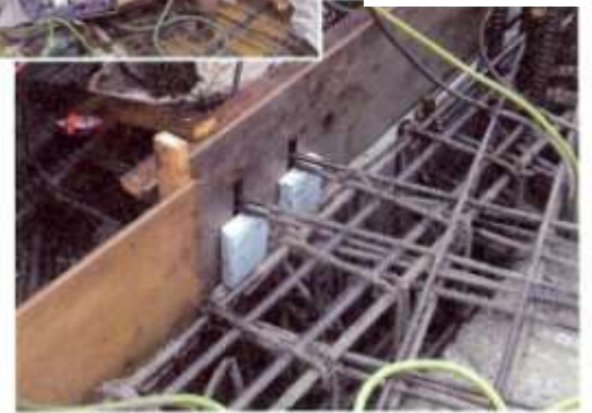
型枠作業が間に合わず、生コンが漏れるのを防ぐために応急処置で対応
