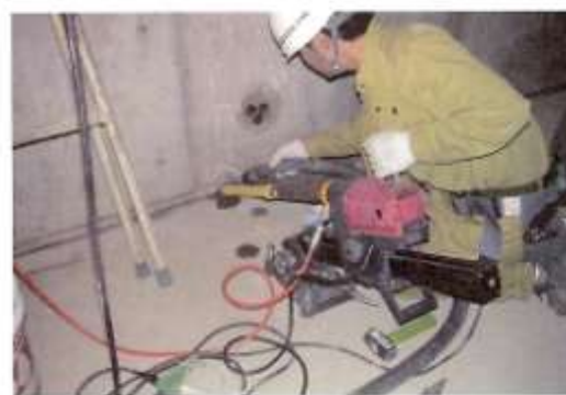
打ち継ぎ部からのコア採取作業
