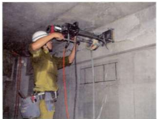
コア採取により打ち継ぎ状態を確認
