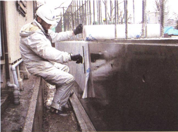
壁面に養生テープを張り付けているところ。ひび割れを防止するためには、できるだけ長期間コンクリートを乾燥から守る必要がある
