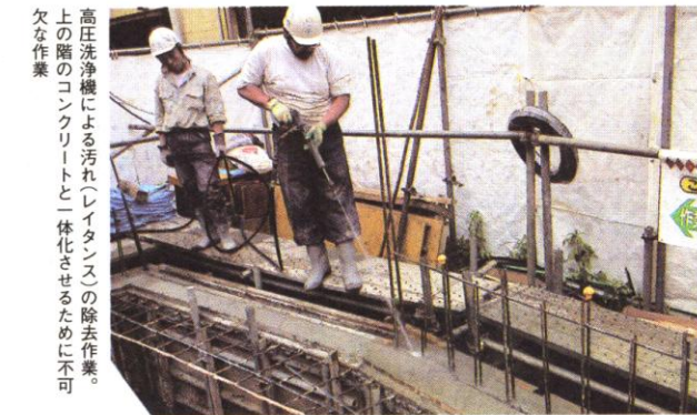
生コン充てん後、時間が経過してゆるんだ生コンに、バイブレーターで再度振動を与えて締め固めている
