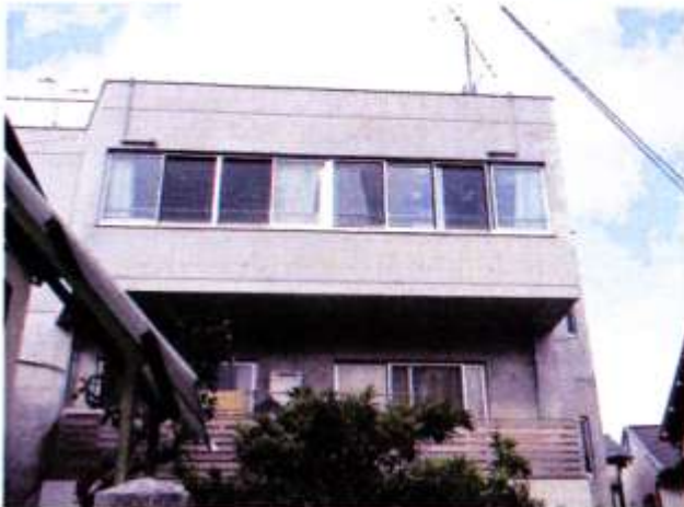
施主も養生作業などを手伝ってつくり上げた、打ち出し仕上げの鉄筋コンクリート造の集合住宅
