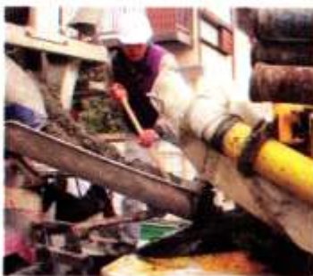
固い生コンを、ミキサー車からスコップを使って荷下ろしする。固い生コンの打設には、多くの作業員が必要になる
