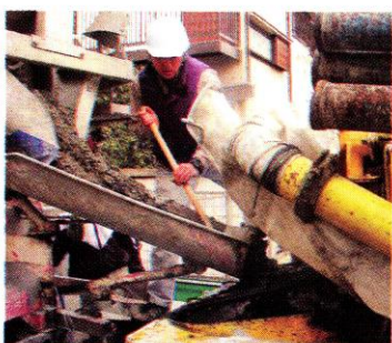
固い生コンを、ミキサー車からスコップを使って荷下ろしする。固い生コンの打設には、多くの作業員が必要になる
