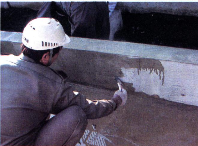
住宅の基礎部分の耐久性を高めるため、コンクリートの表面に水ガラスを塗布しているところ
