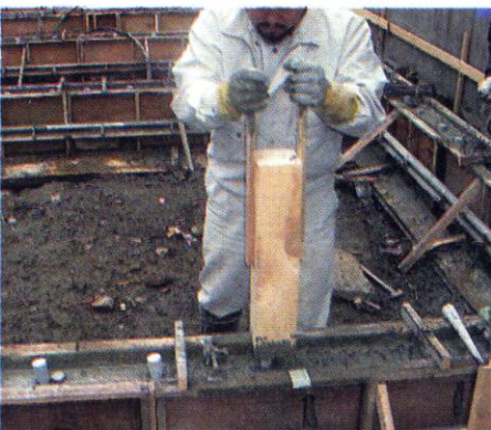
型枠に詰めたコンクリートに、密度向上ピースをたたき込む。そうすることで、コンクリート中のすき間がなくなり、耐久性がより高まる
