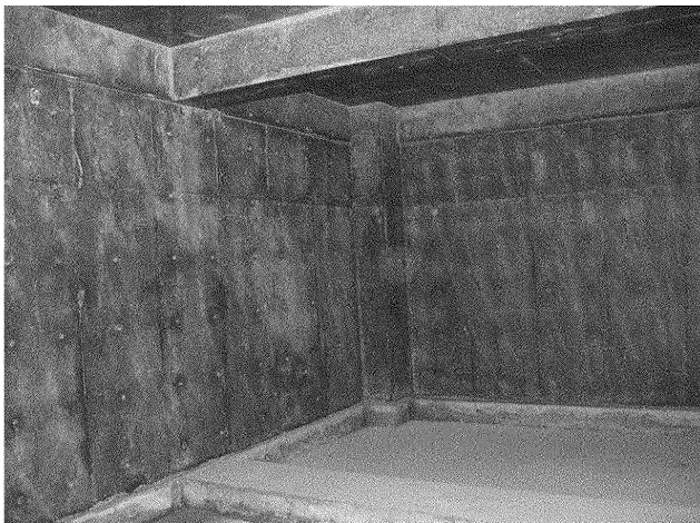
住宅地下室（型枠解体後）
